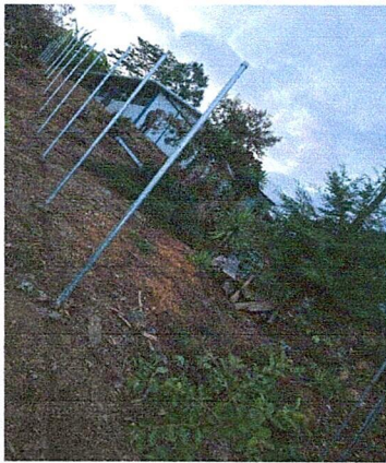
Foto 3: ASÍ SE VEÍA EL PROYECTO EN PLENA EJEEECUCIÓN
